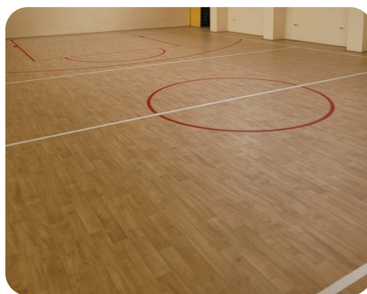
Fragment wyremontowanej nawierzchni sali sportowej
