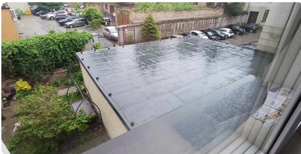
Dach po naprawie
