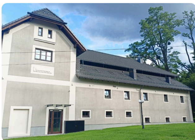
Spichlerz - tył budynku
