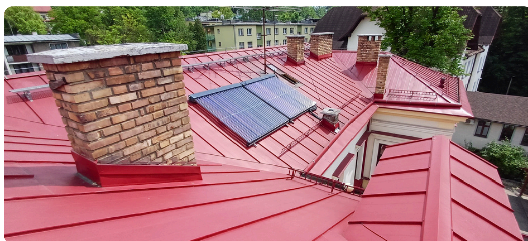
Fragmety wyremontowanego dachu
