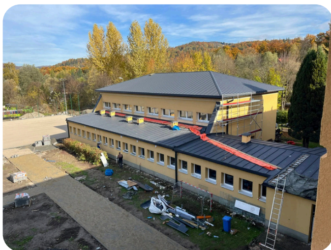
W trakcie prac termomodernizacyjnych
