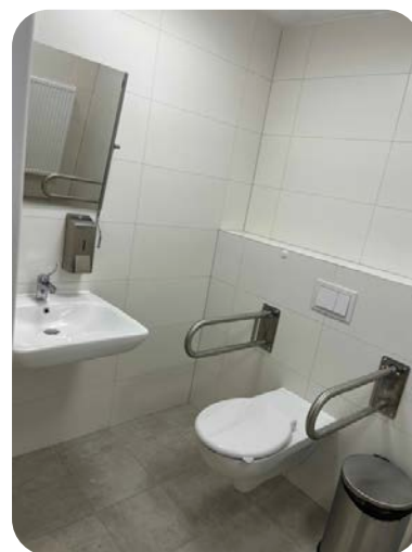
Sanitariat po modernizacji
