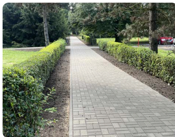
Fragment wyremontowanego chodnika
