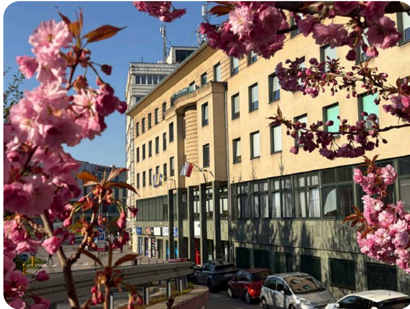
Budynek przy ul. Bobreckiej 29
