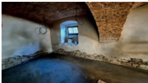
Zdjęcie nr 6. Planowana sala warsztatowa na parterze
