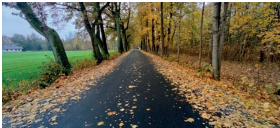
Zdjęcie nr 80 i 81 . ul. Wyremontowana ul. Rolna w Zabłociu
