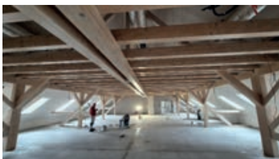
Zdjęcie nr 4. Prace na I piętrze Spichlerza
