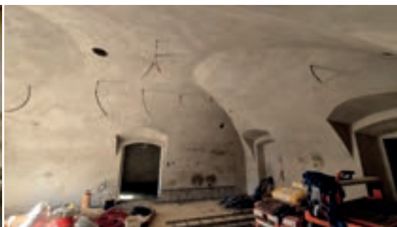
Zdjęcie nr 7. Planowana kawiarnia na parterze
