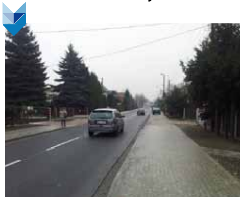
Przebudowa ul. Góreckiej w Skoczowie.
