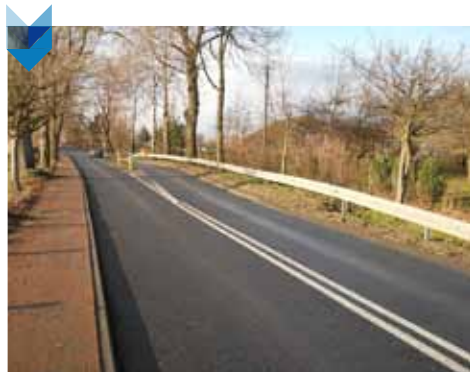
Przebudowa drogi przez Centrum Pruchnej.
