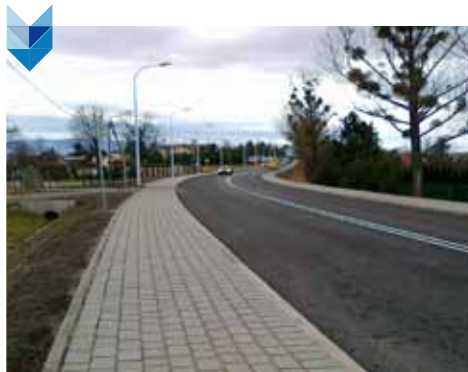
Przebudowa drogi powiatowej ul. Bielska w Cieszynie.
