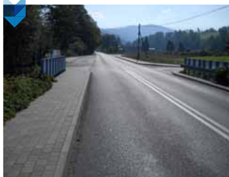
Przebudowa drogi od ul. Miodowej do ul. Malinowej w Brennej.
