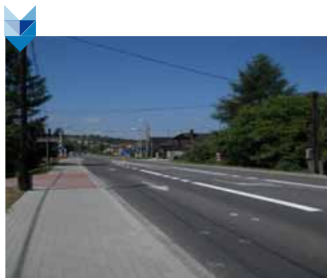
Przebudowa ul. Bielskiej w Skoczowie.
