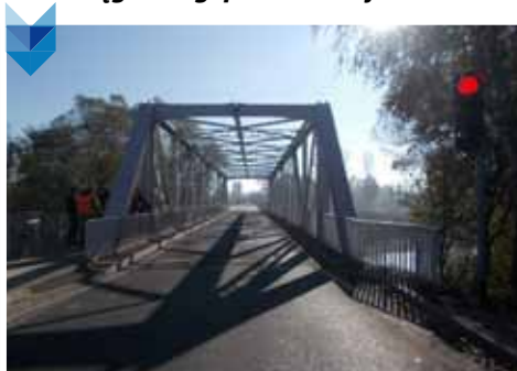
Modernizacja mostu na Wiśle w Strumieniu w ciągu drogi powiatowej 2633 S.
