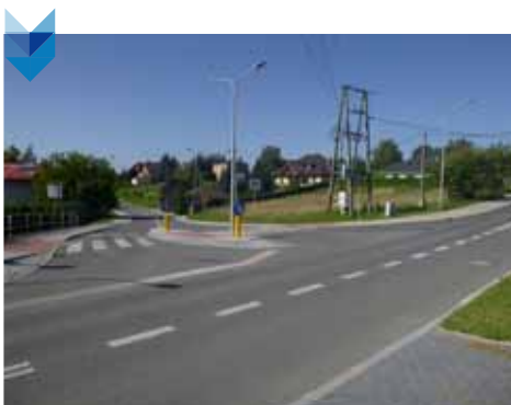
Rozbudowa z przebudową ul. Pikiety w Cieszynie.
