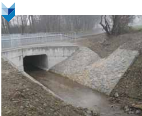
Przebudowa przepustu na potoku Wschodnica w ciągu drogi powiatowej 2601 S Górki – Szpotawice w Górkach Wielkich.
