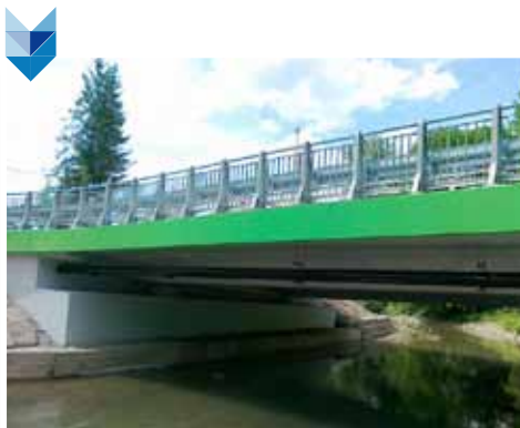
Przebudowa mostu nad rzeką Pucówką w ciągu Al. Jana Łyska w Cieszynie.
