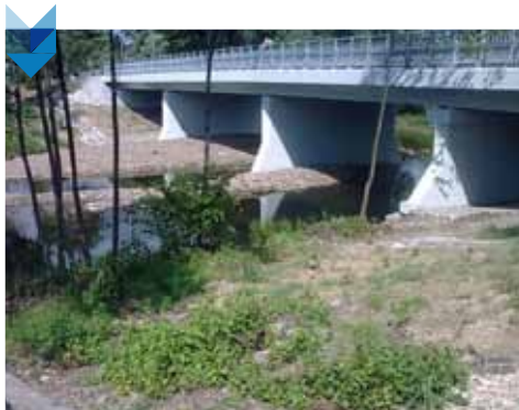
Przebudowa mostu nad rzeką Brennica.
