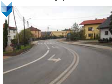
Przebudowa ul. Długiej w Zabłociu.
