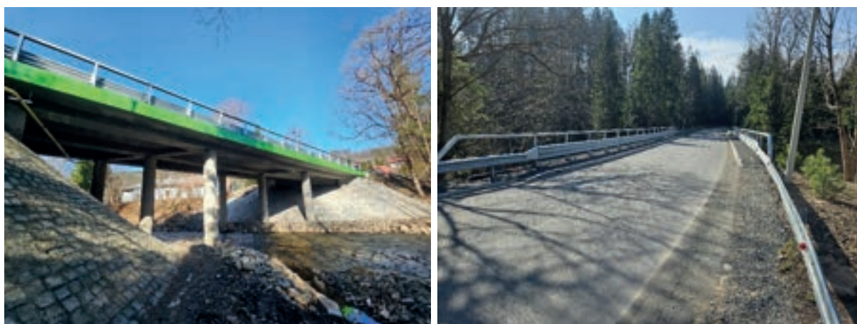
Zdjęcie nr 84 i 85. Zmodernizowany most nad Białą Wiselką w ciągu ul. Czarne w Wiśle.
