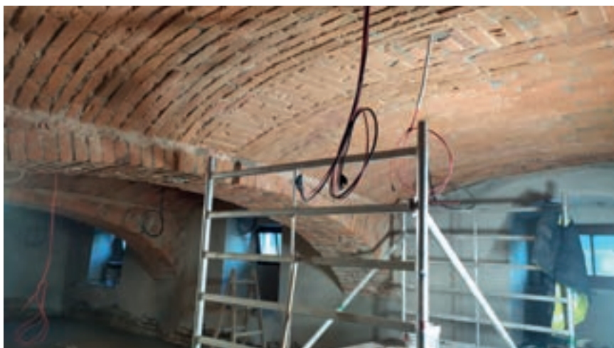
Zdjęcie nr 59. Wnętrze w trakcie prac remontowych
