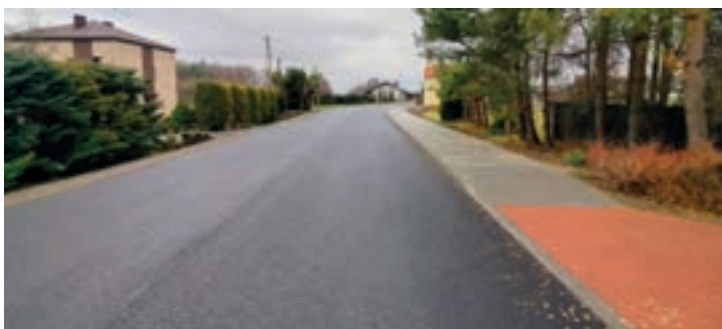
Zdjęcie nr 66 i 67. Przebudowa drogi powiatowej 2625S ul. Konopnickiej w Kaczycach
