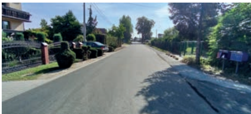
Zdjęcie nr 82 i 83. ul. Wyremontowana ul. Wiejska w Drogomyślu
