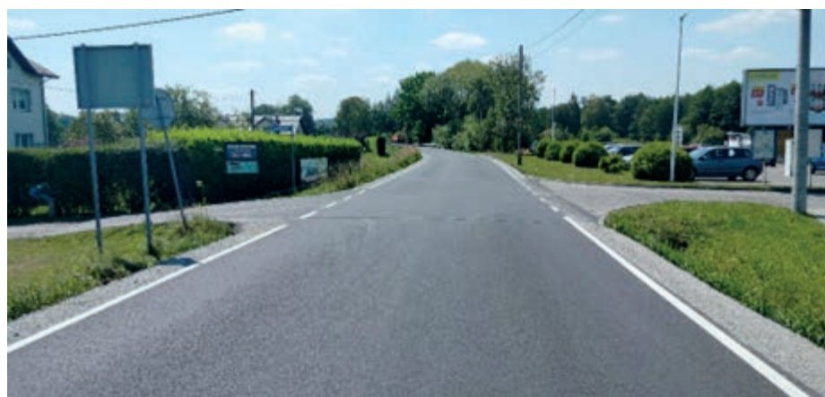
Zdjęcie nr 78 i 79. Wyremontowana ul. Pierściecka w Kiczycach
