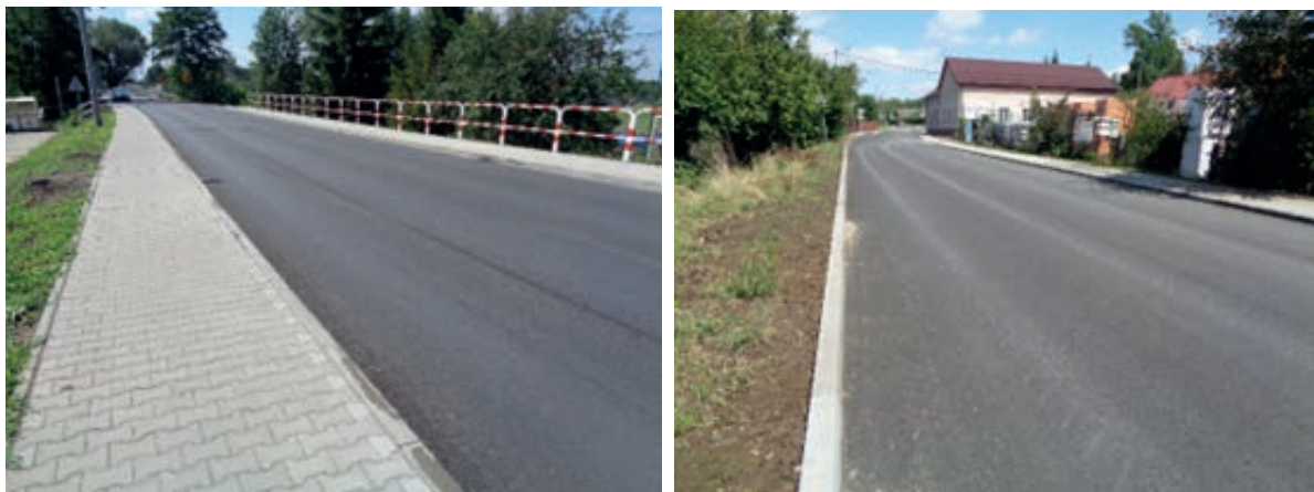
Zdjęcie nr 68 i 69. Wyremontowana ul. Bielska w Górkach Wielkich
