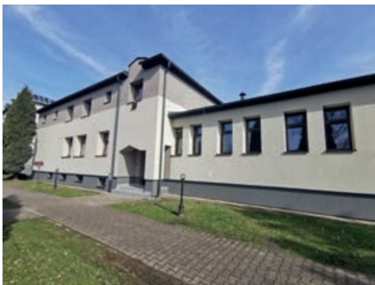
Zdjęcie nr 55. Budynek po termomodernizacji
