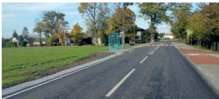
Zdjęcie nr 72 i 73. Wyremontowana ul. Cieszyńska w Mnichu
