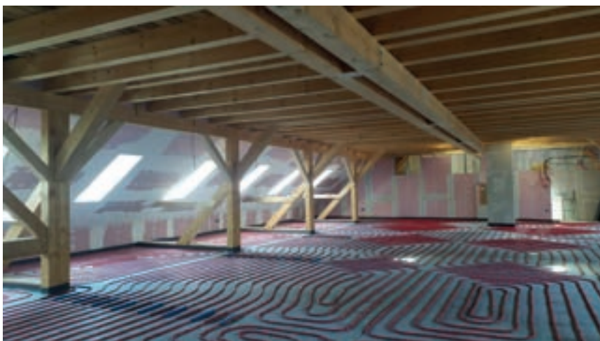
Zdjęcie nr 58. Wnętrze w trakcie prac remontowych
