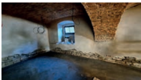
Zdjęcie nr 6. Planowana sala warsztatowa na parterze
