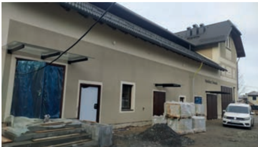
Zdjęcie nr 57. Budynek w trakcie prac remontowych
