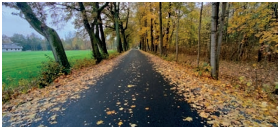
Zdjęcie nr 80 i 81 . Wyremontowana ul. Rolna w Zabłociu
