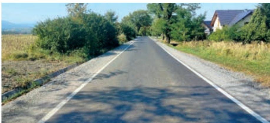
Zdjęcie nr 74 i 75. Wyremontowana ul. Wichrowa w Gumnach
