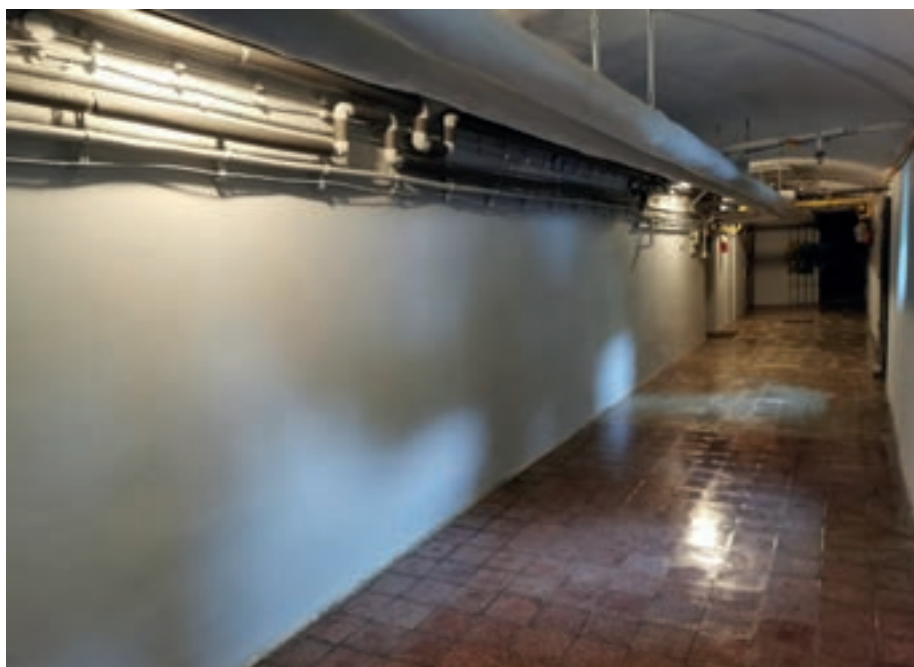
Zdjęcie nr 54. Wyremontowany korytarz piwnicy
