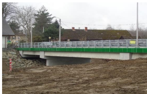
Zdjęcie 58. Nowy most nad rz. Wisłą (2)
