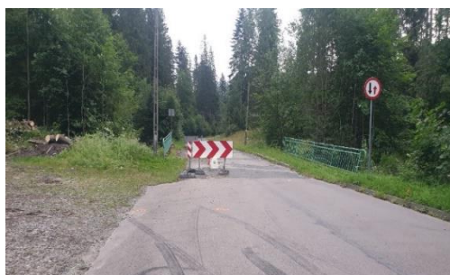
Zdjęcie 53. ul. Dziehcinka w Wiśle przed remontem
