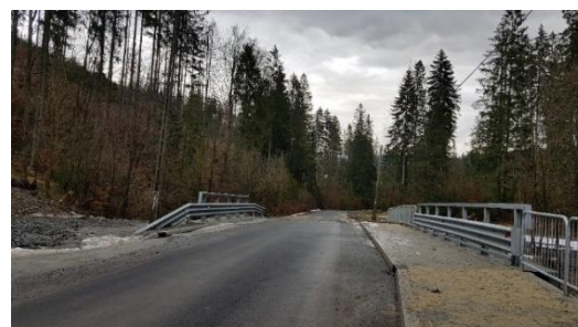
Zdjęcie 54. ul. Dziehcinka po remoncie
