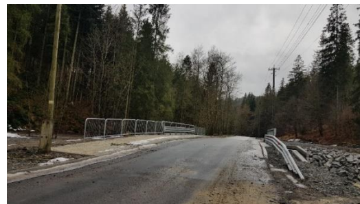
Zdjęcie 52. Nowy most na potoku Dziehcinka
