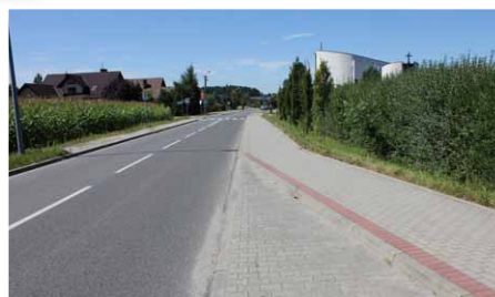
Przebudowa drogi Goleszów – Hermanice – Ustroń, w tym budowa chodników i ścieżki rowerowej.
