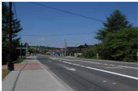
Przebudowa ul. Bielskiej w Skoczowie.
