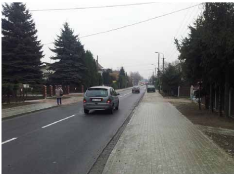
Przebudowa ul. Góreckiej w Skoczowie.
