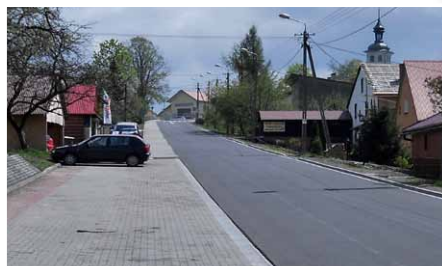
Przebudowa drogi w Istebnej, w tym przebudowa chodników, zatok autobusowych i dróg bocznych.
