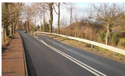
Przebudowa drogi przez centrum Pruchnej.
