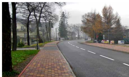
Przebudowa drogi powiatowej Skoczów - Brenna wraz z budową obustronnych chodników.
